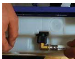
Serrage d'un raccord MeplaFix jusqu'en butée.
