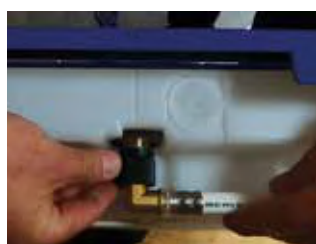
Montage d'un raccord MeplaFix sur l'arrivée d'eau de bâti-support pour WC en 1/2".
