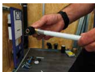
Assemblage d'un raccord MeplaFix 90° avec tube Geberit Volex (réf. 618.430.00.1).
