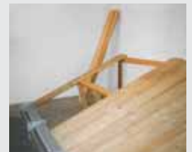
Ossature porteuse de base
