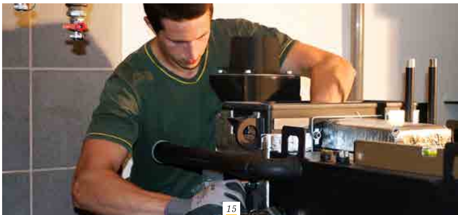
KWB Multifire – chaudière démontable en 4 parties
