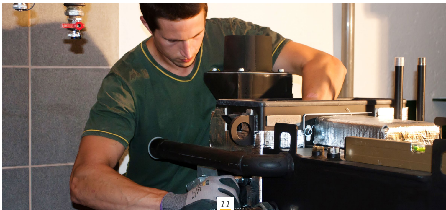
KWB Pelletfire Plus – chaudière démontable en 4 parties
